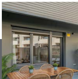
Perfileria PVC amb doble vidre termoacústic.
