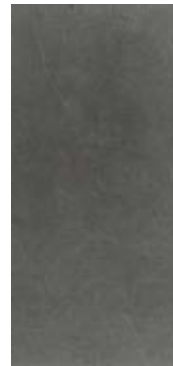
Aplacado zona lavabo Washbasin area cladding
